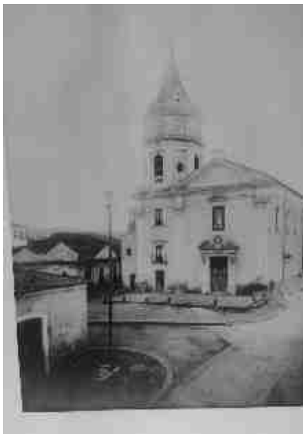
La chiesa di S. Maria di Monserrato del 1764 come la vide Don Giovanni Longo, che fu Rettore fino al 26 dicembre 1925 Sulla sinistra, in via S. Pietro, ai numeri civici 1-9 possiamo vedere le antiche costruzioni ancora esistenti.
